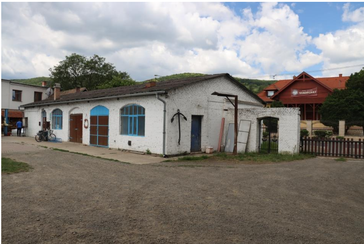
A főépület udvari, délkeleti és északkeleti homlokzata
