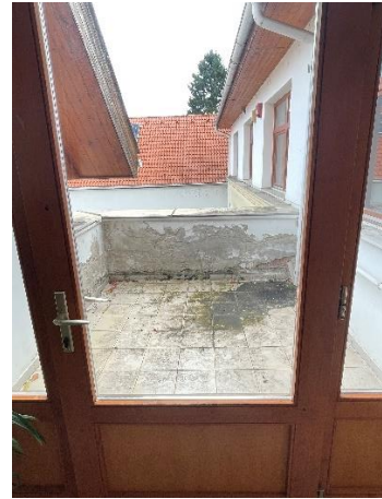
Emeleti terasz beázás nyomokkal
