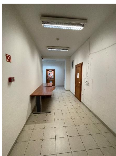
Közlekedő lépcsőház felől
