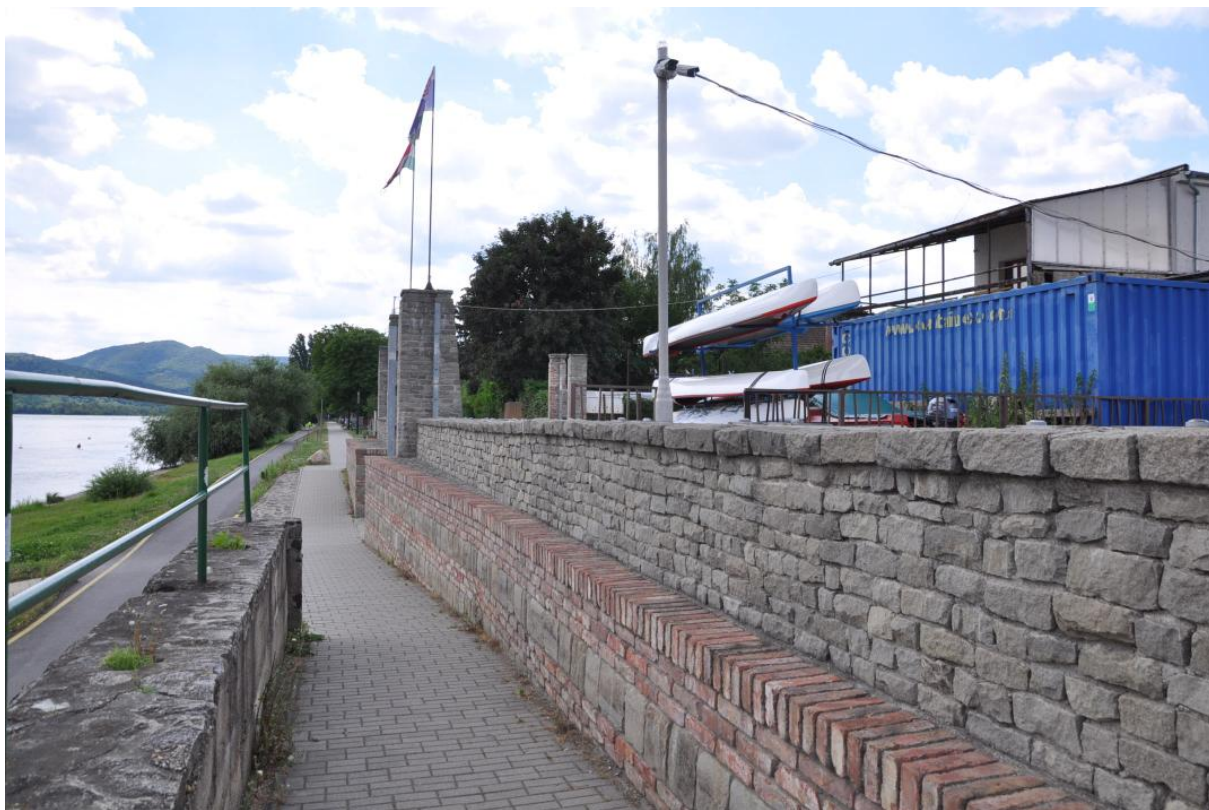
Az ingatlan alatt húzódó, közvetlen kapcsolatot adó sétányszakas
