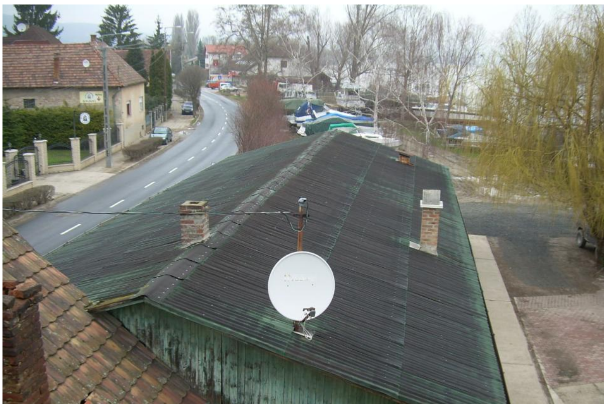
Az elbontandó épület a szomszéd ingatlan felől nézve
