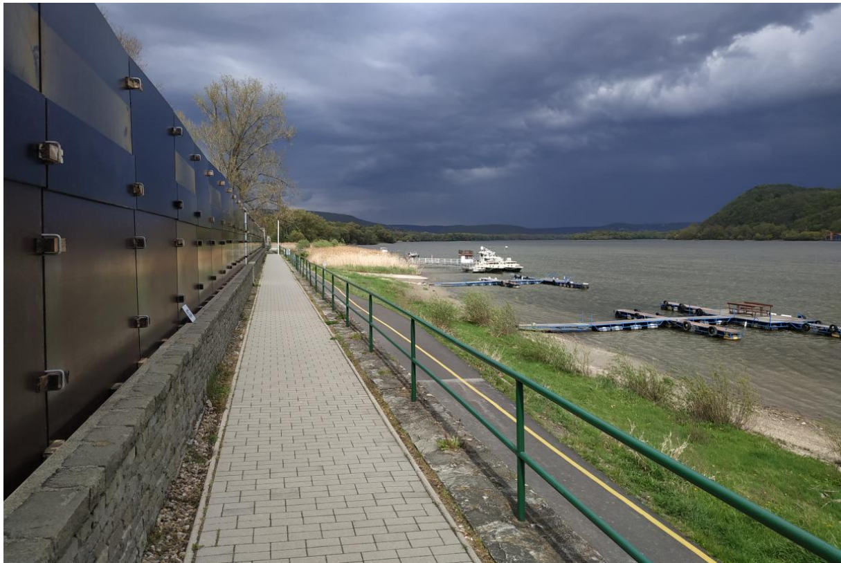
A sétányszakasz, árvízi védekezés idején felállított mobilgát-rendszerrel
