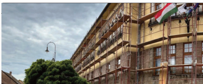
Hőszigetelő burkolatot kapott az iskola
