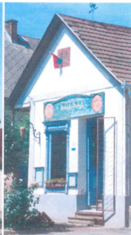
Helyi védelem alatt álló épület hangulatos felújítása, ötletes és egyedi részletekkel, díszletláblával és cégérrel.
