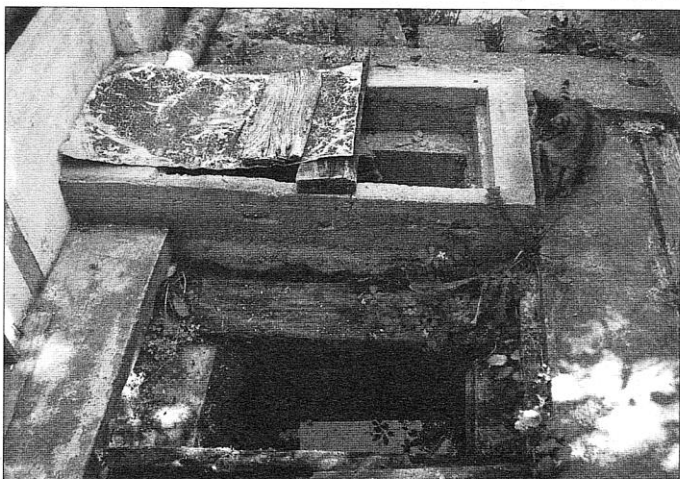
Házi építésű, deszkákkal takarható, beton falú ciszterna
