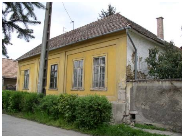
a felújítás előtt 2005
