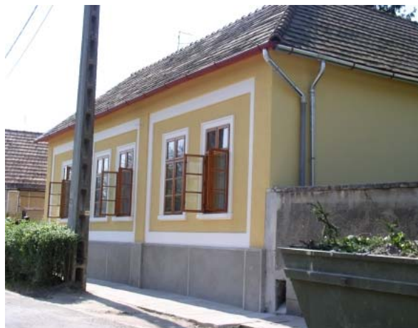
a felújítás után 2006
