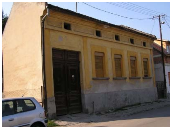
a felújítás előtt 2005
