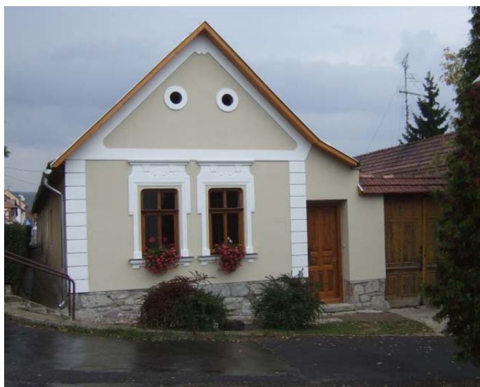
a felújítás után 2007
