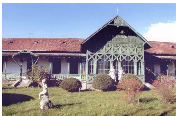
a felújítás előtt 2003
