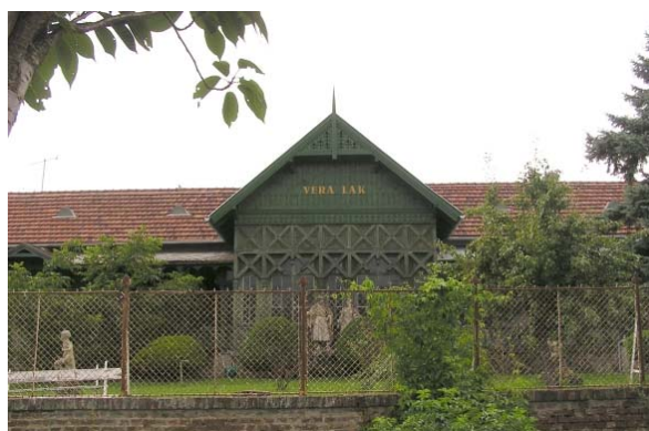
a felújítás után 2004
