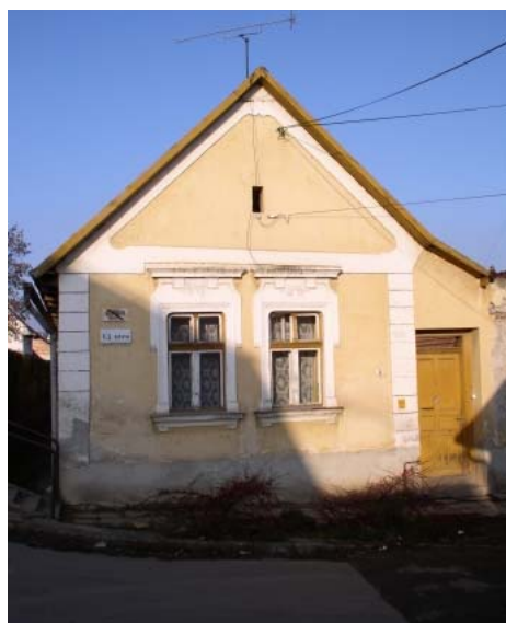
a felújítás előtt 2004
