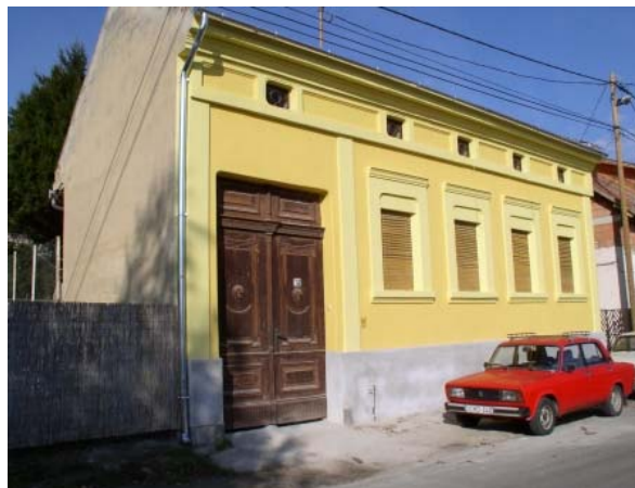
a felújítás után 2006
