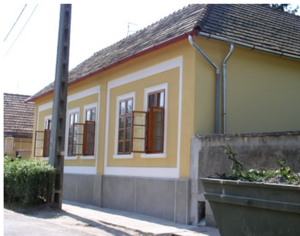
a felújítás után 2006
