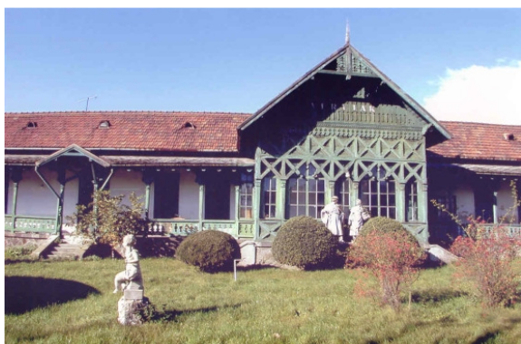
a felújítás előtt 2003
