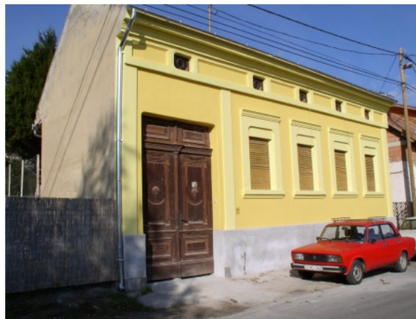
a felújítás után 2006
