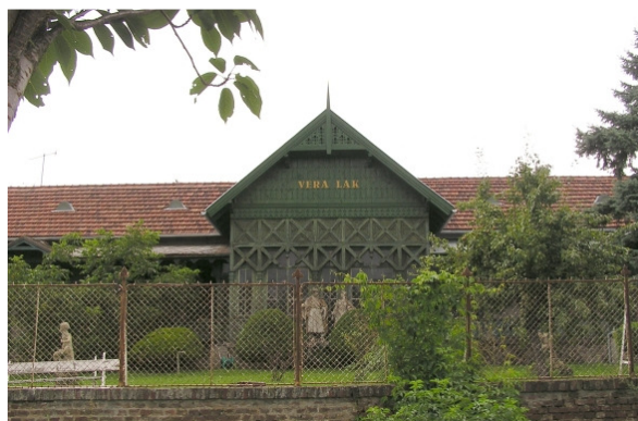
a felújítás után 2004
