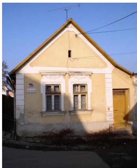
a felújítás előtt 2004
