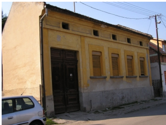
a felújítás előtt 2005
