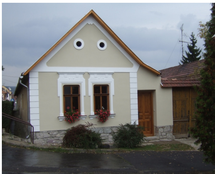
a felújítás után 2007
