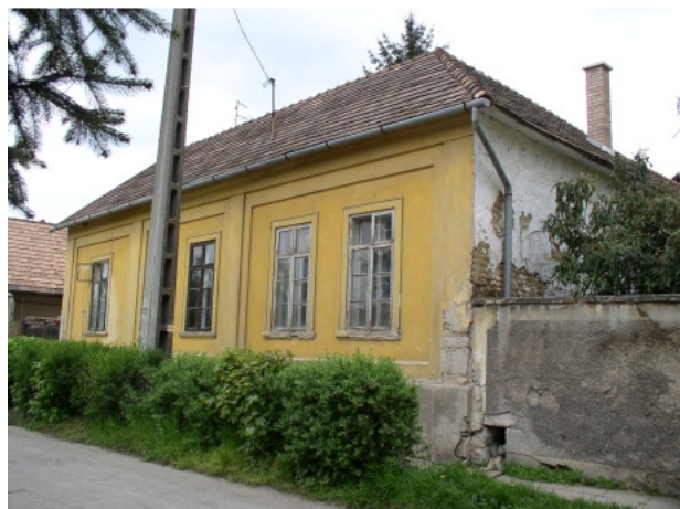
a felújítás előtt 2005
