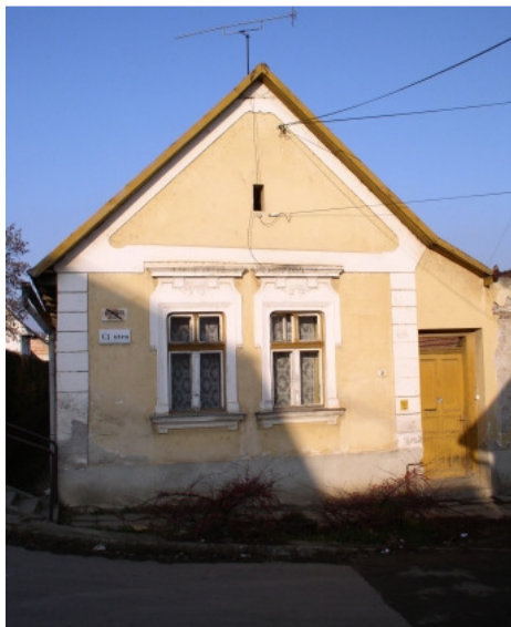
a felújítás előtt 2004
