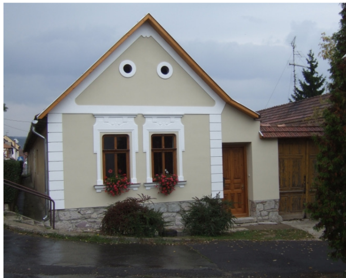
a felújítás után 2007
